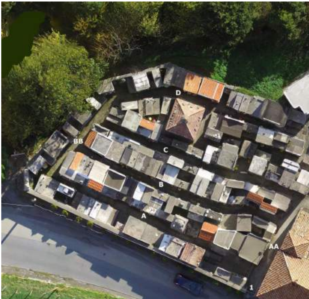
Cimitero Vecchio: Viali A, B, C, D, AA e BB e cancello n. 1 (foto Nicola Paoli)
