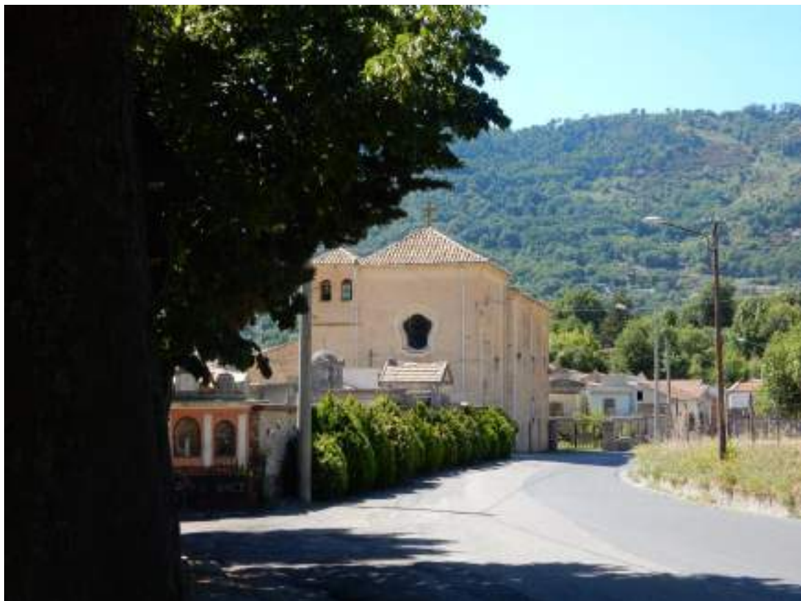
Chiesa e Campanile della Chiesa di S. Maria del Soccorso e una parte del Cimitero Nuovo di Lago. Il Campanile fu ribassato nel 1911 a causa dei danni subiti dai terremoti del 1905 e 1908 (Foto F. Gallo)
