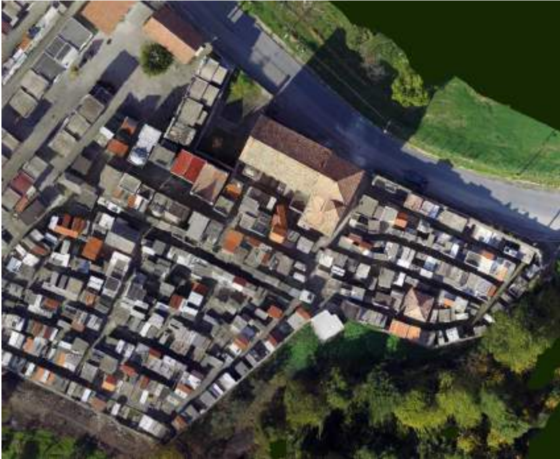
Parte Vecchia del Cimitero di Lago- Old Section of Lago's Cemetery
